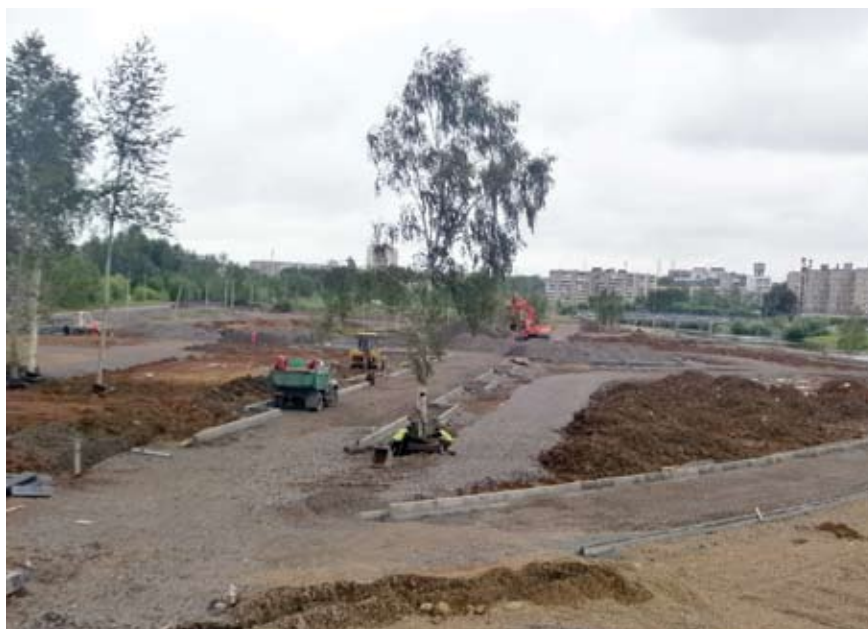
Стройплощадка парка «Народный»
