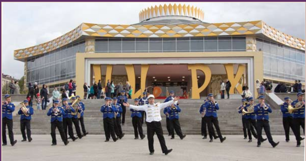
Вот он, красавец, отремонтированный цирк
