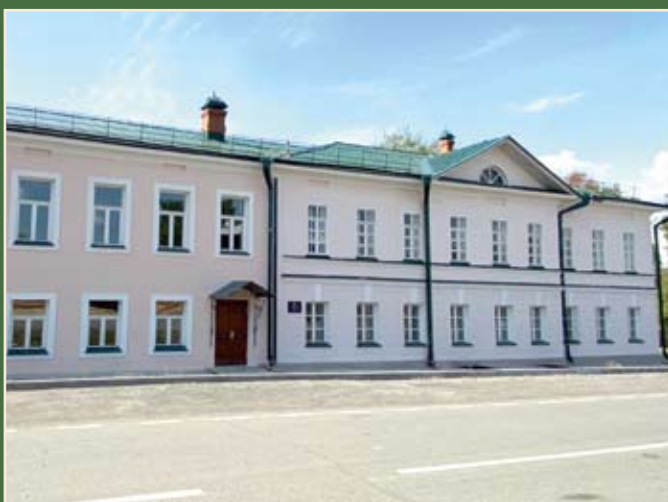
Общественное здание после реставрации
