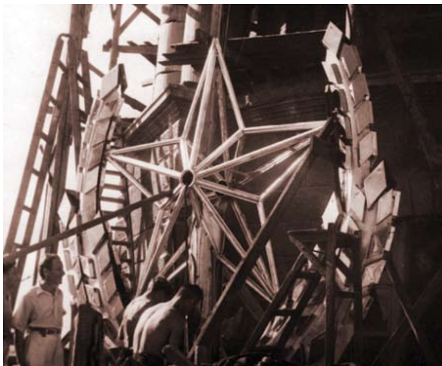
Монтаж и подъем звезды на шпиль здания горсовета (первый слева стоит М. РЕЙШЕР). 1954 год
