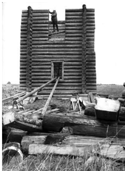
Воссоздание пожарной сторожевой башни. 1979 год
