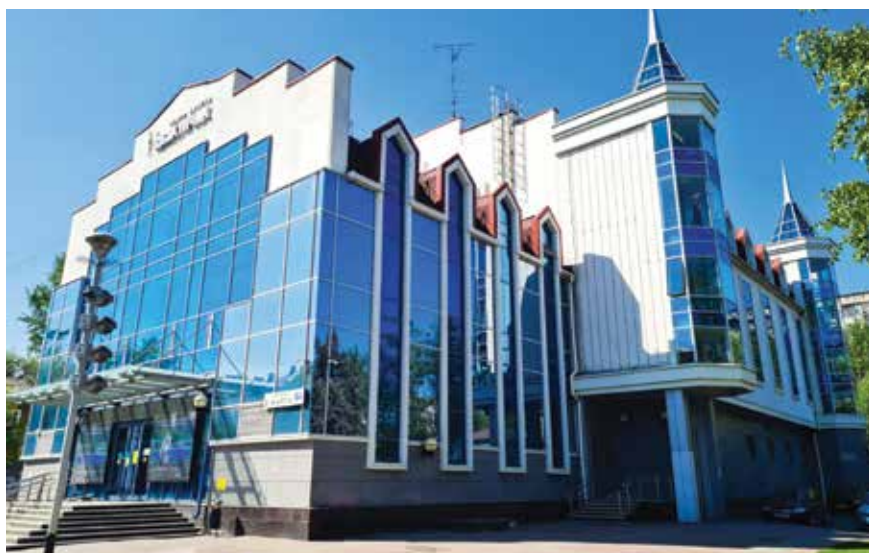
Здание Театра балета «Щелкунчик»
