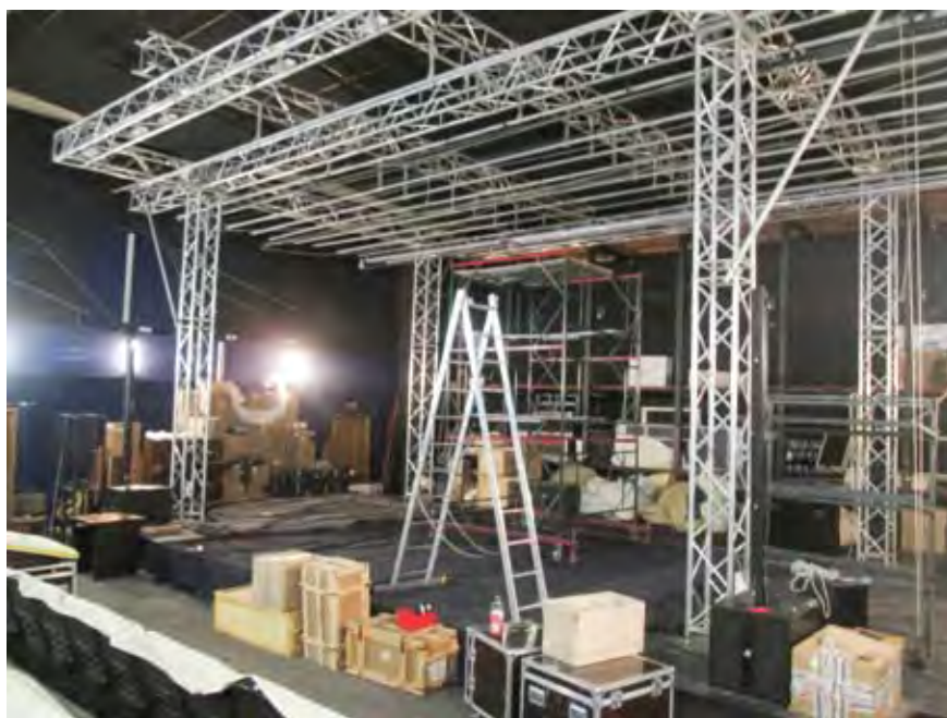
Большой зал. Коробка сцены, каркас
