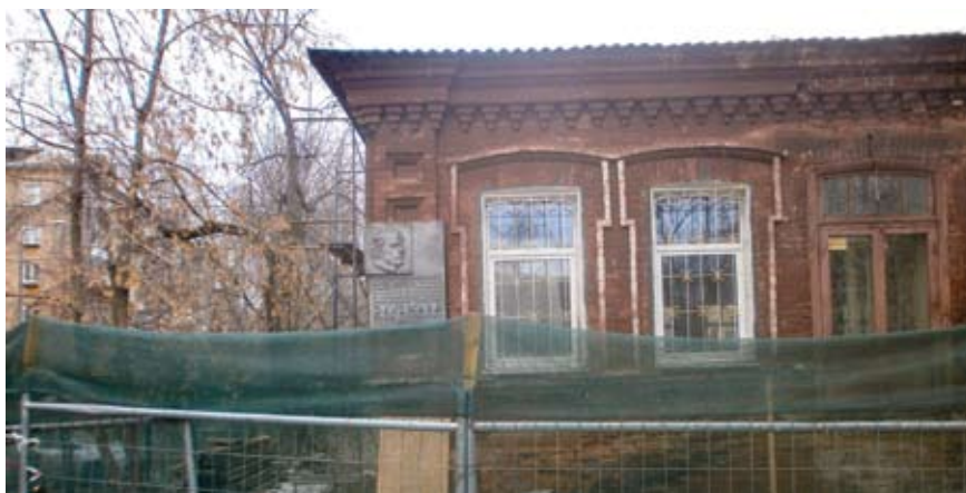
Идет работа по реконструкции
