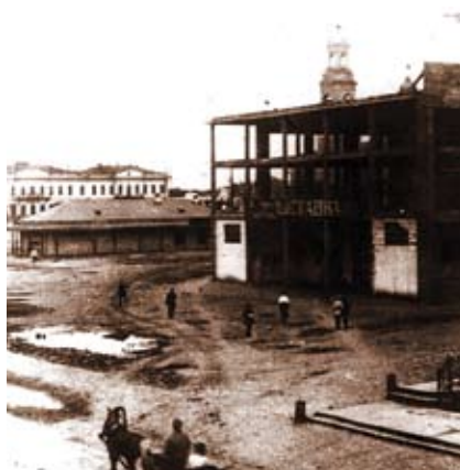
Будущая улица Вайнера, справа каркас будущего «Пассажа»
