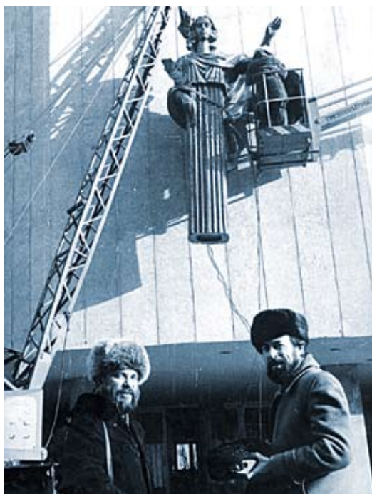
Монтаж Музы. Андрей АНТОНОВ и архитектор Борис ДЕМИДОВ. Ноябрь 1984 года
